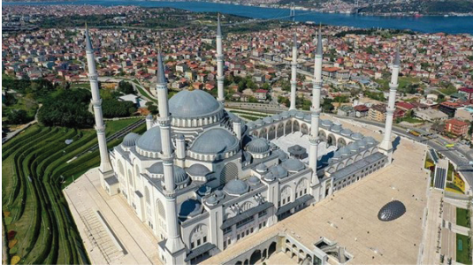
Şekil 10. Büyük Çamlıca Camii Genel Görünüm
